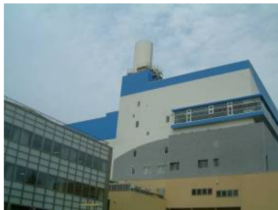
南西方向から望む葛飾清掃工場
