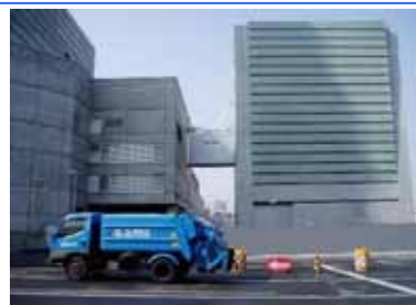
完成した飛灰搬出設備(右側の建物)
