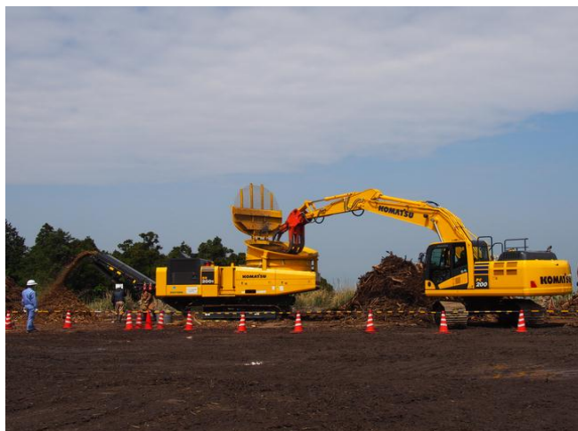
選別後破碎機で破碎処理
