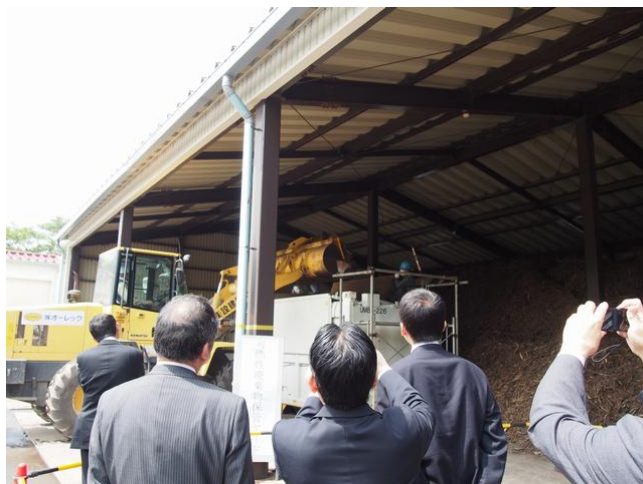
破碎処理された木くずのコンテナ積込作業
