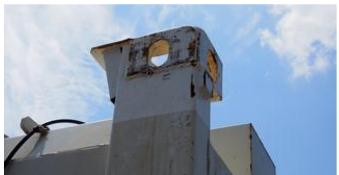
クレーンフックを掛けるため改造したコンテナ上部
