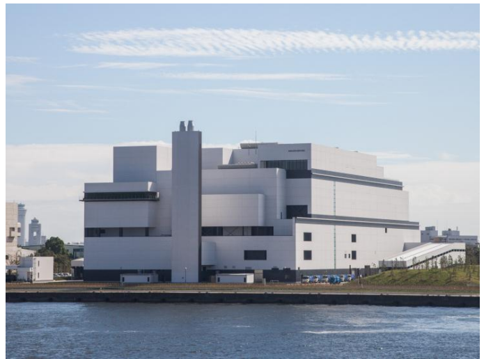
しゅん工した大田清掃工場
