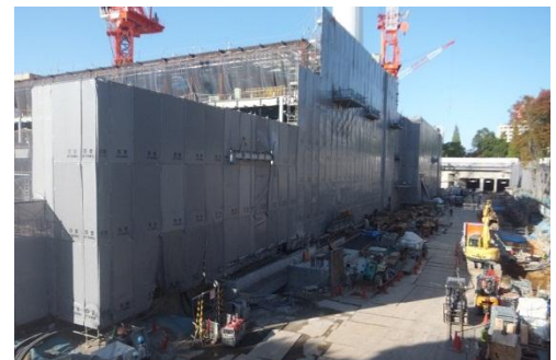
建設中の杉並清掃工場
