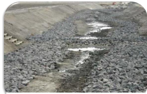
多自然型河川改修工事（施工事例）
