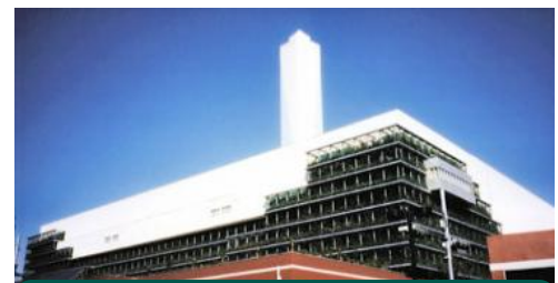
板橋清掃工場
