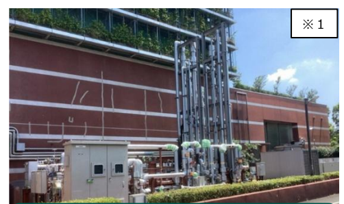
可搬式CO 2 回収装置設置状況
