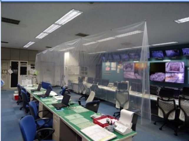
取組風景（葛飾清掃工場 中央制御室）間仕切り
