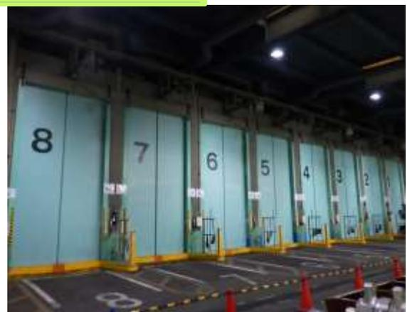
ごみ搬入時に、ごみバンカの投入扉を自動開閉する設備が「ごみバンカゲート」です。バンカゲートの更新を行います。
