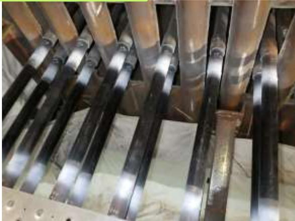
焼却熱から蒸気を発生させる設備がボイラで、過熱器で蒸気をさらに高温にします。老朽化した過熱器の部分更新を行います。
