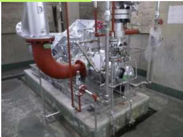
ボイラに給水をするための設備が「ボイラ給水ポンプ」です。劣化したポンプの更新を行います。
