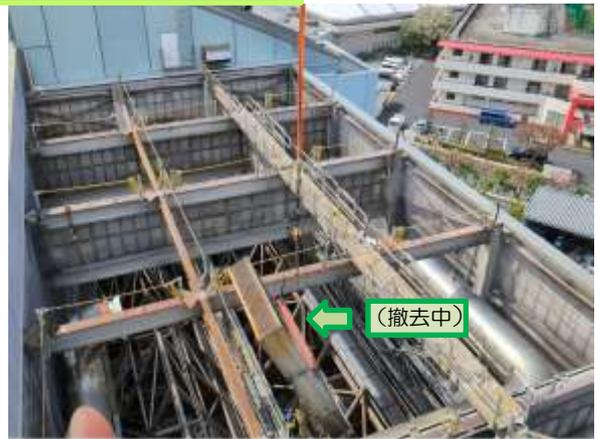
蒸気タービンで発電に使用された蒸気を水に戻す設備が「タービン排気復水器」です。復水器の更新を行います。
