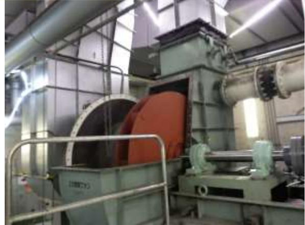
焼却炉に燃焼用空気を送る設備が「2次燃焼ファン」です。劣化した部品の部分更新を行います。
