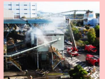
粗大ごみ破碎処理施設での火災
