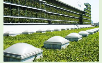
屋上緑化(板橋清掃工場)
