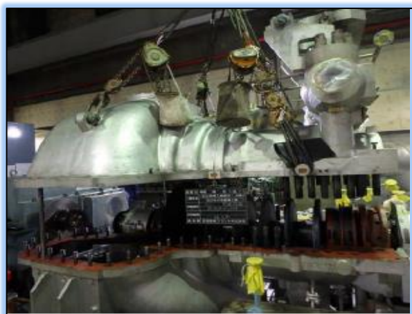
【蒸気タービン開放点検の様子】
