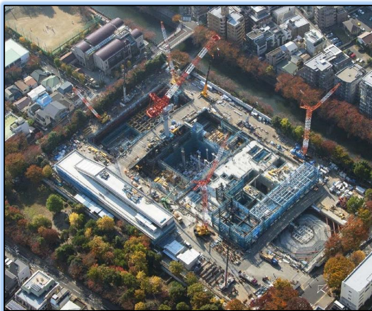
【目黒清掃工場建替工事の様子】
