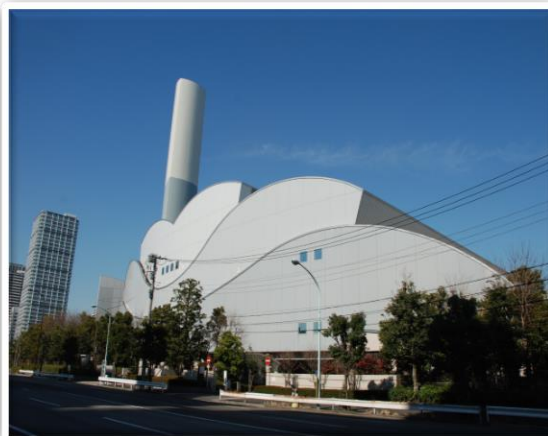
港清掃工場【外観】
