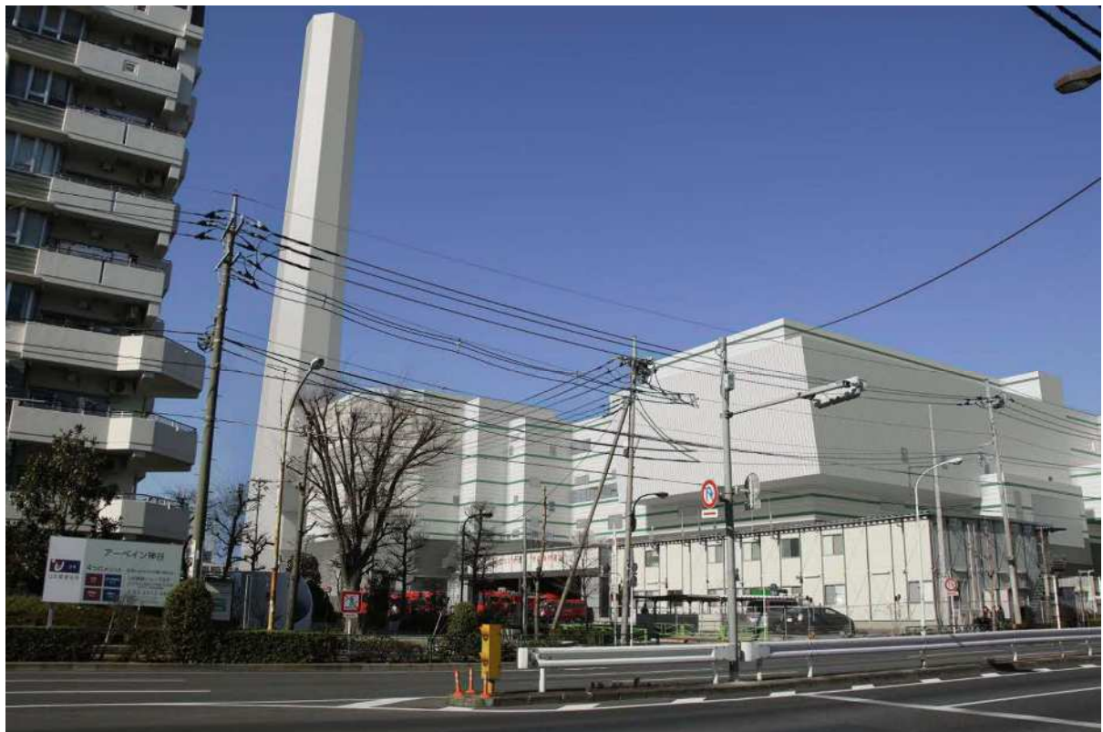
写真 6.5-3(1) 地点③ 北本通りからの景観（現況）
