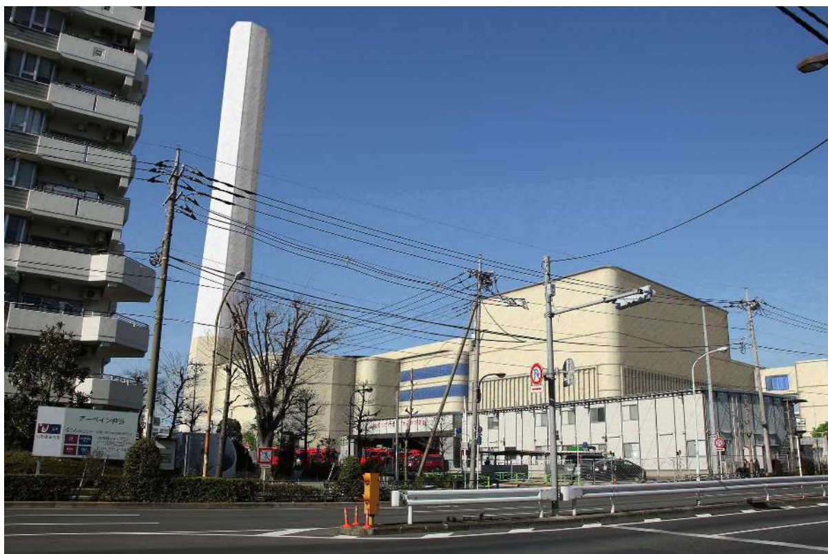
写真 6.5-3(3) 地点③ 北本通りからの景観（現況）
