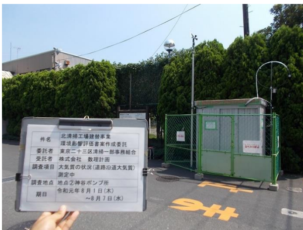
神谷ポンプ所 地点②
