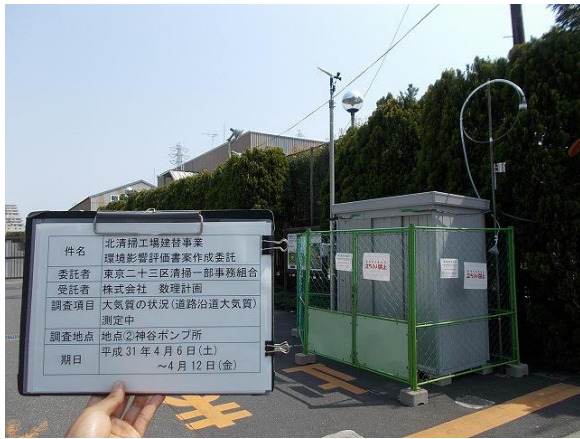
神谷ポンプ所 地点②
