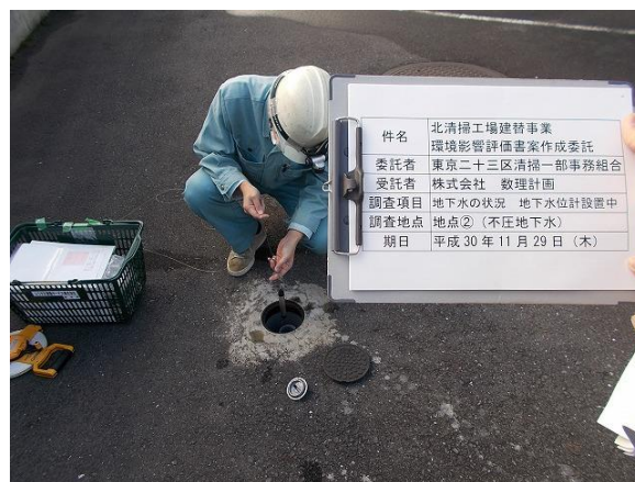
地点② (不圧地下水)
