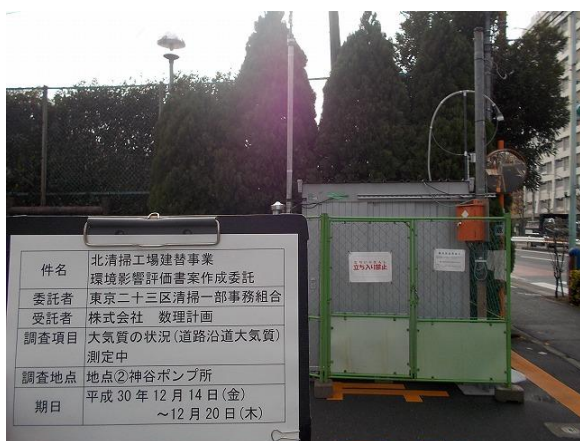
神谷ポンプ所 地点②
