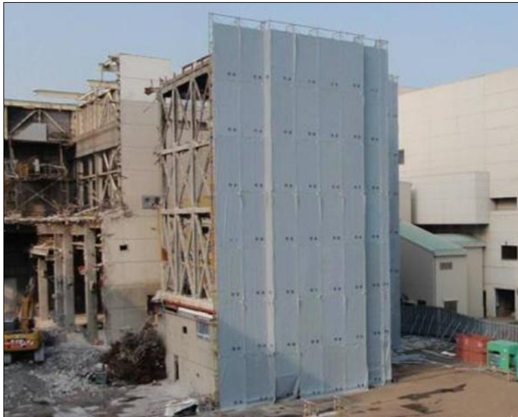
解体中の防音シート設置状況
