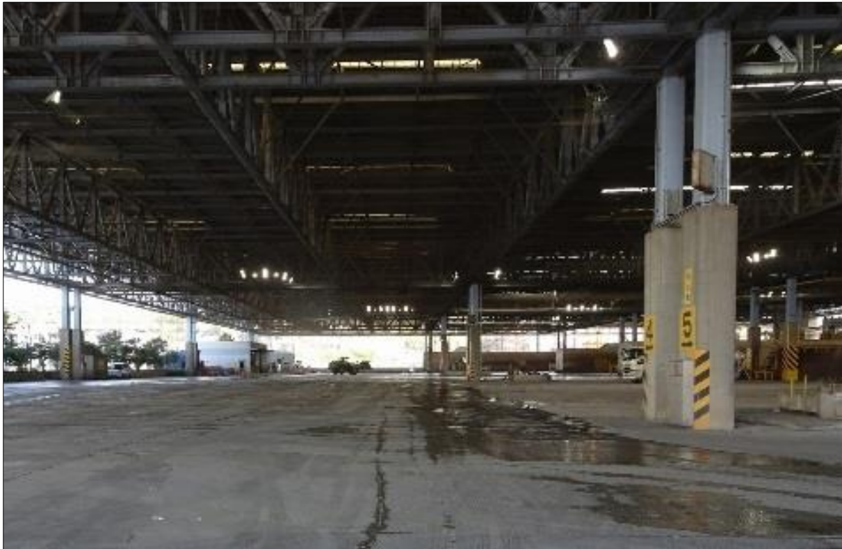
中防不燃ごみ処理センター受入ヤード
