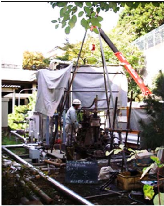
▲ボーリング調査の様子
