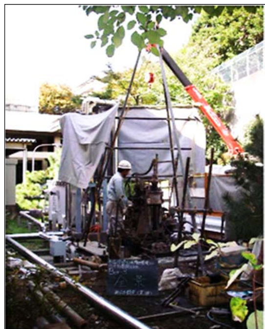
▲地盤調査の様子
