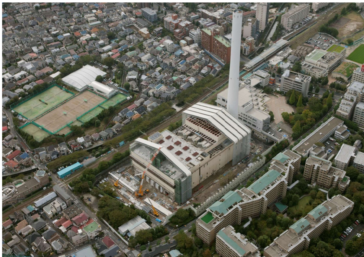
工場棟テント組立
