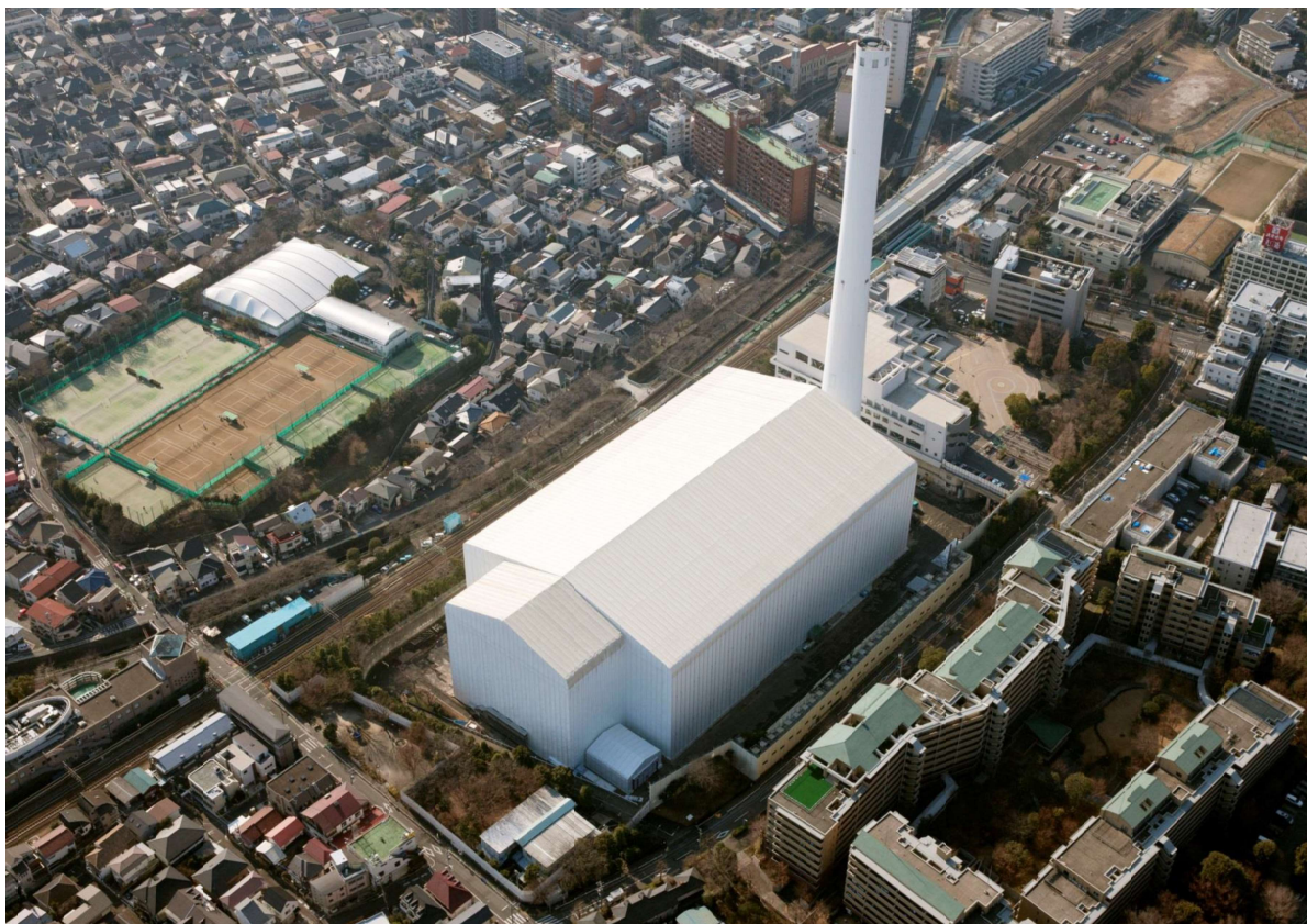
工場棟テント設置
