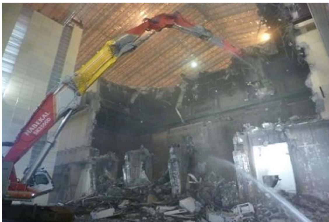
テント内部の解体の様子
