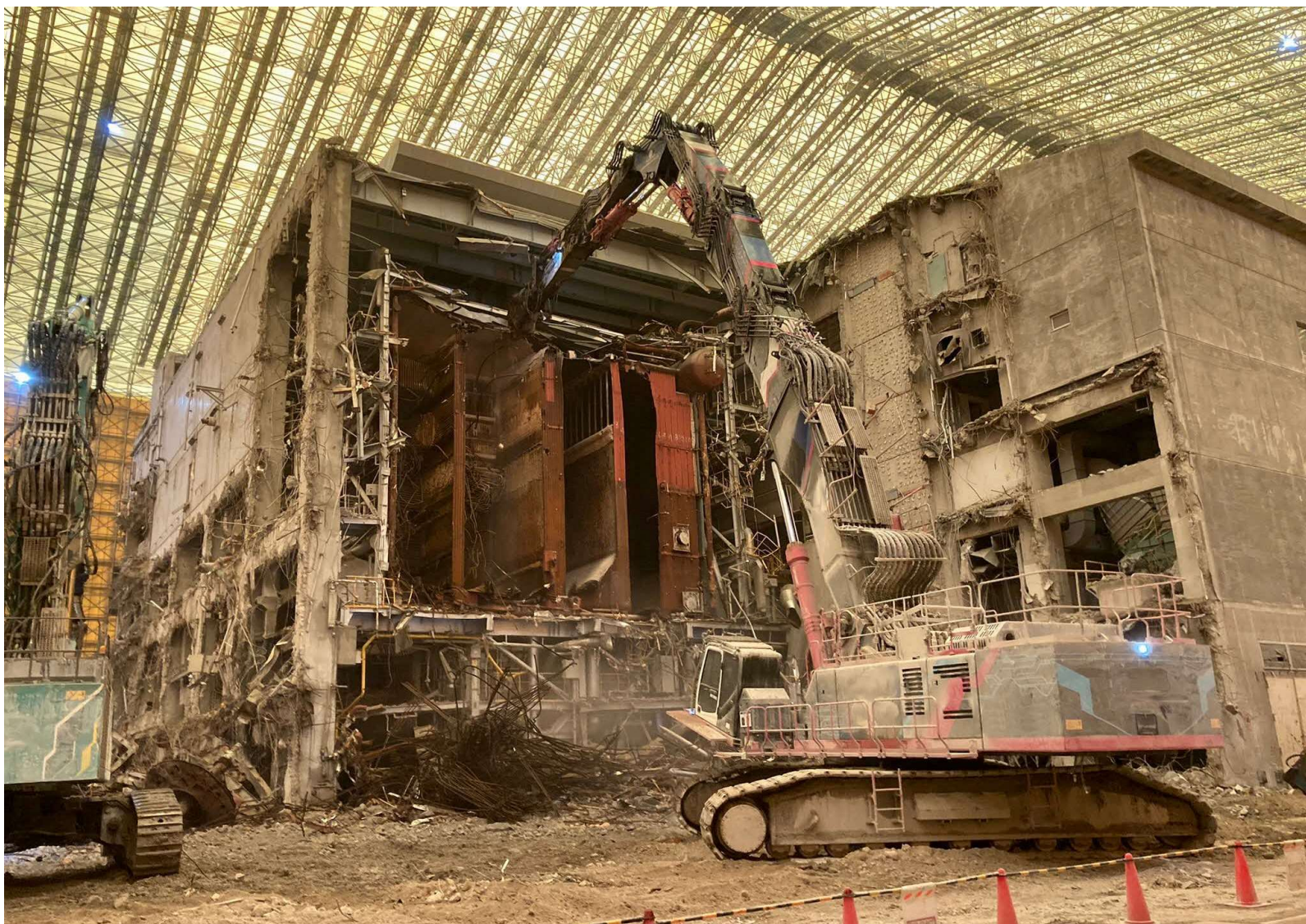
仮設テント内部の解体の様子
