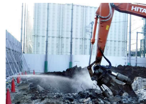
発泡性溶液散布状況
