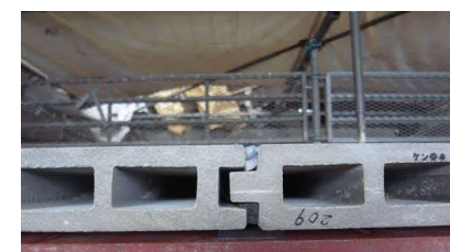
押出成形セメント板 (ジョイント部)
