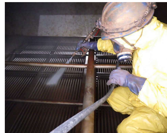
高圧水洗浄作業例 (蒸気式再加熱器内部)
