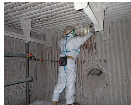
工具を用いた除去例 (ボイラー内部)
