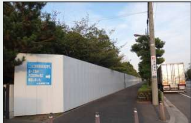
工事用フェンスの設置
