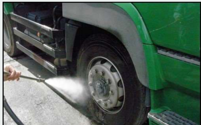
工事用車両のタイヤ洗浄の実施
