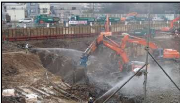
工事作業エリア等に適宜散水
