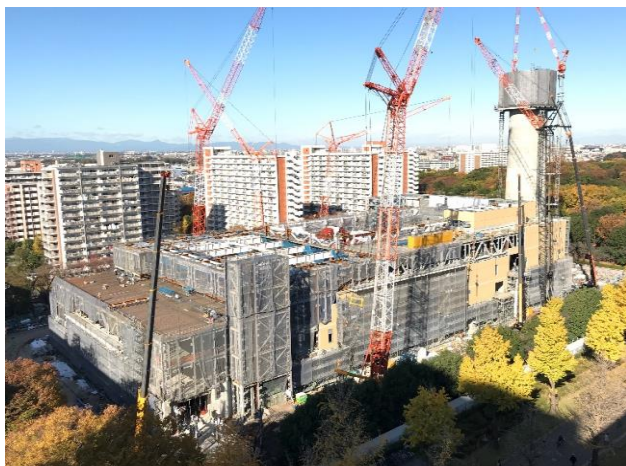
【工事状況写真(令和元年11月)】
