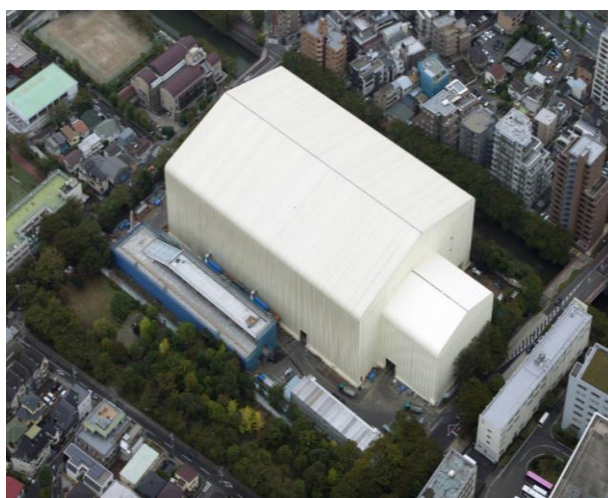
【工事状況写真(令和元年10月)】
