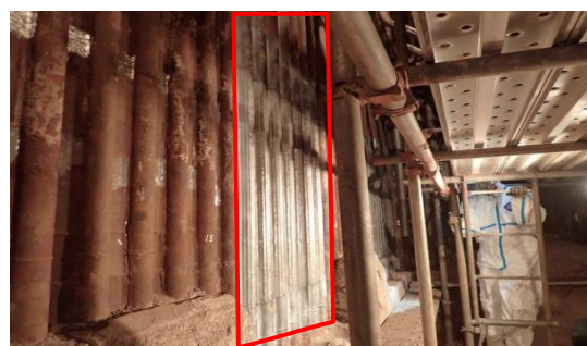
【新しいボイラ水管】
