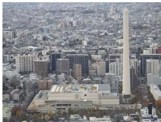
【建替工事(目黒清掃工場)】
