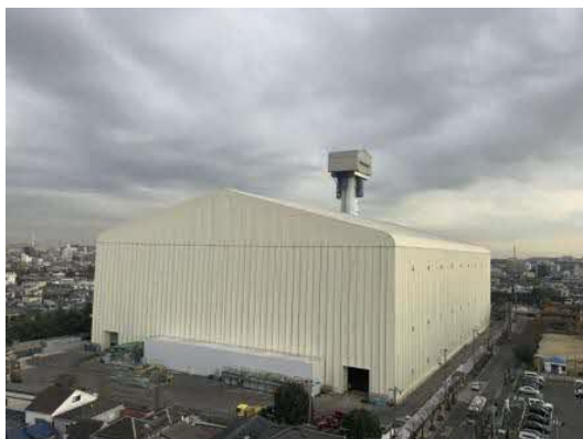
【建替工事(江戸川清掃工場)】
