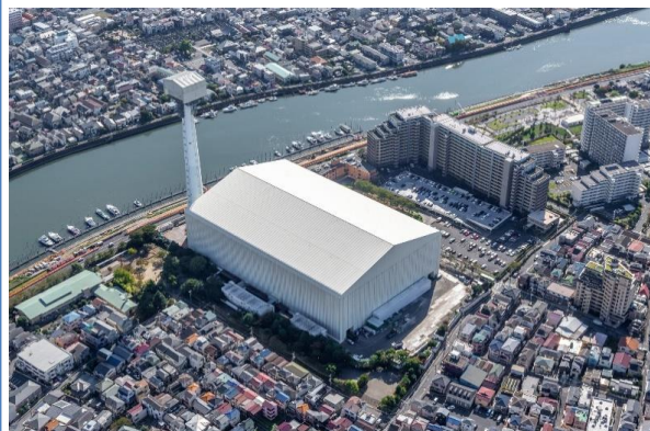
【工事状況写真】(令和4年10月)
