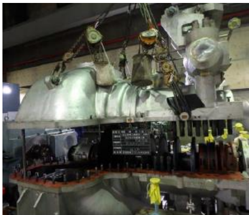
【蒸気タービンの開放点検(発電設備)】
