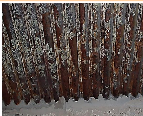
【既設のボイラ水管】
