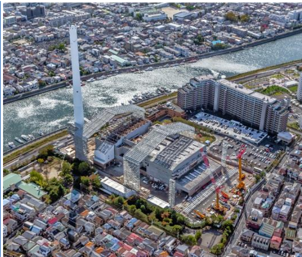
【工事状況写真】(令和3年10月)
