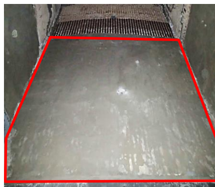
【耐火物施工後】
