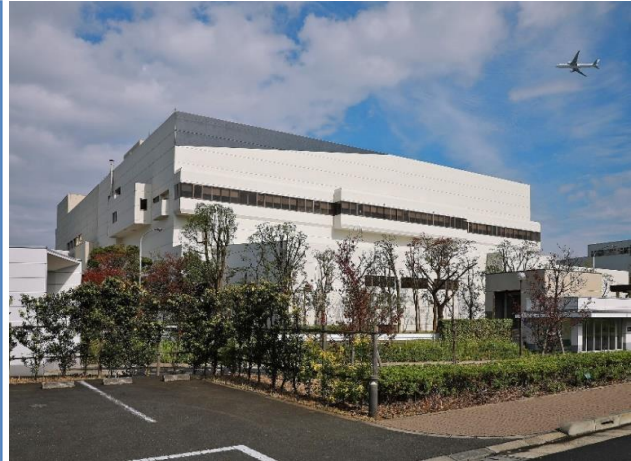
【外壁補修後状況写真】(令和3年10月)
