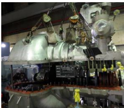
【蒸気タービンの開放点検(発電設備)】
