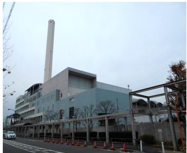
【工場全景写真】(令和3年11月)
