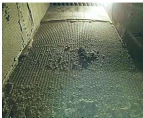
【耐火物施工前】
