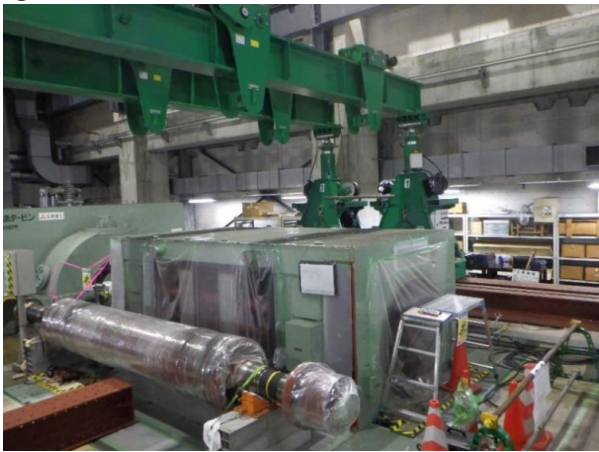
【発電機更新状況写真】(令和3年11月)
