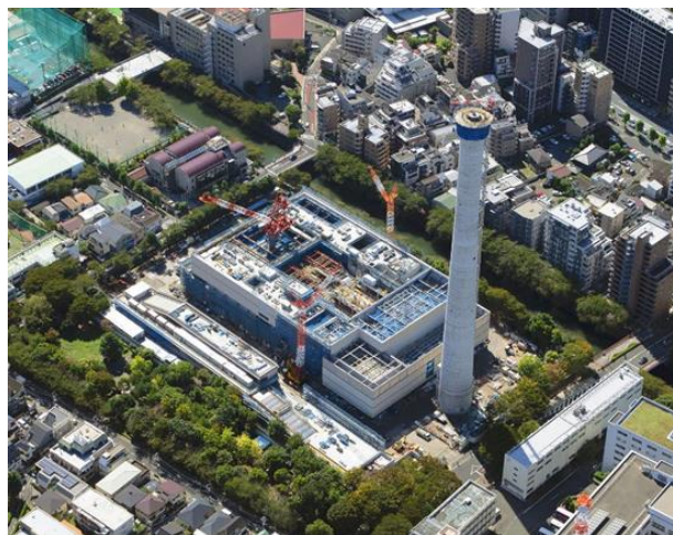
【工事状況写真】(令和3年10月)
