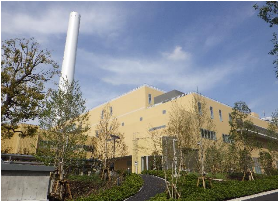
【建替工事(光が丘清掃工場)】
