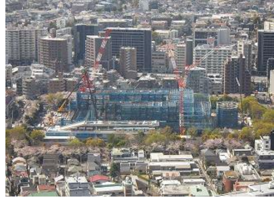
【建替工事(目黒清掃工場)】
